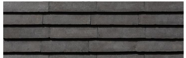
Skærmtegl lagt som klinkbeklædning
