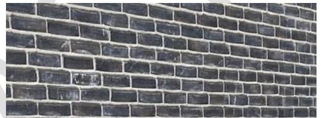
Denne sten eller mørkere opfylder lokalplanens bestemmelser, hvis de fuges med samme mørke farve som stenene.
